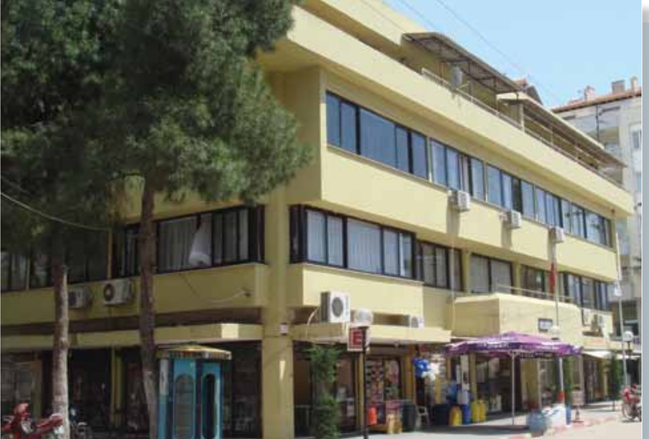
Ahmetli Belediye Binası
