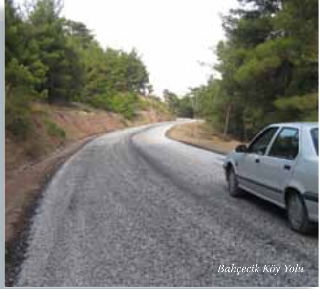
Köylere Parke Taşı Döşeme Çalışması
